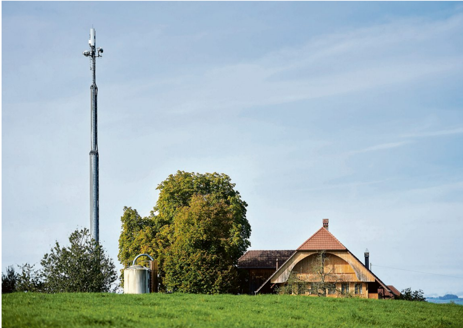
Diese Antenne in der Landwirtschaftszone in Jaberg brachte den Fall ins Rollen. Foto: Adrian Moser
